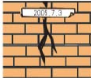
在墙体裂缝上贴纸条
